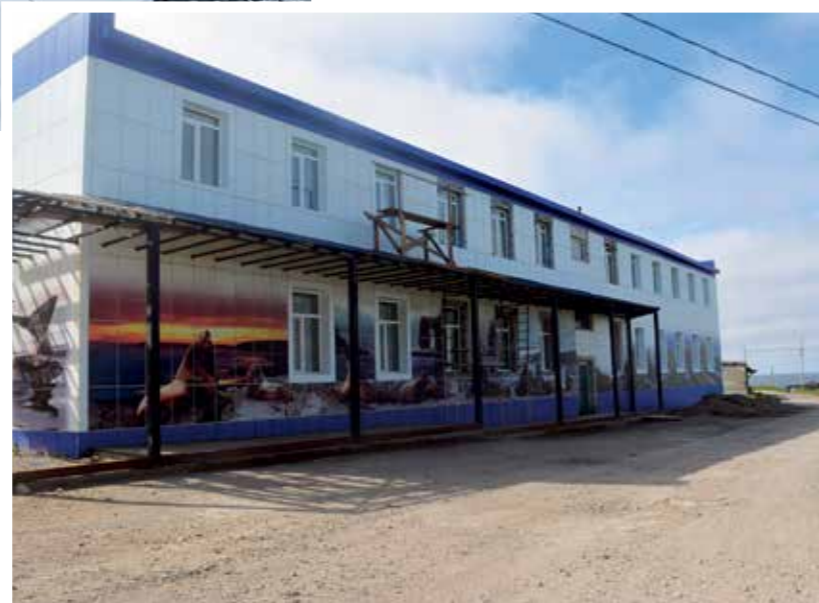
Визит-центр заповедника в процессе ремонта
