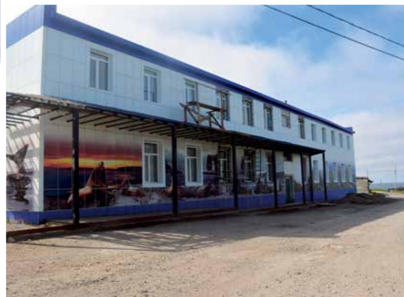
Визит-центр заповедника в процессе ремонта
